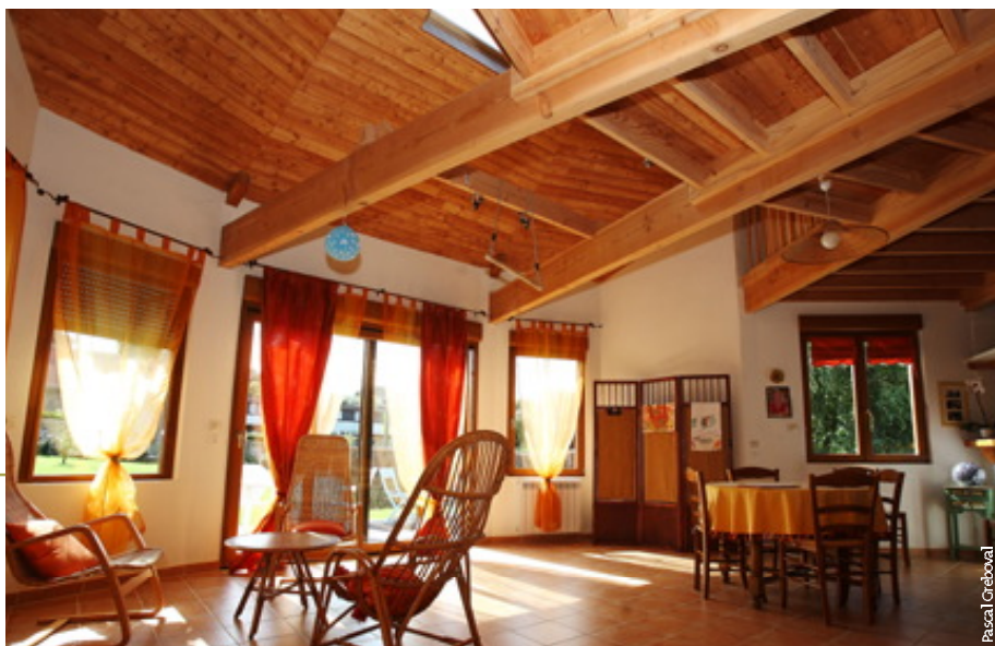
La charpente apparente, limite visuellement la hauteur de la pièce.
